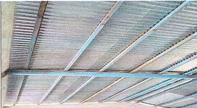
Foto 3. Sustitución de láminas, estructuras metálicas y mantenimiento de puertas.
