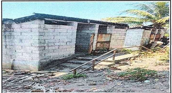
Foto 2: Sustitución de techo y estructura de metal de sanitarios
