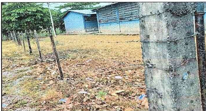
Reparación de Cercos de Alambre.
