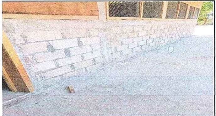
Foto 4: Reparación, repellos y cernidos de paredes de cocina.
