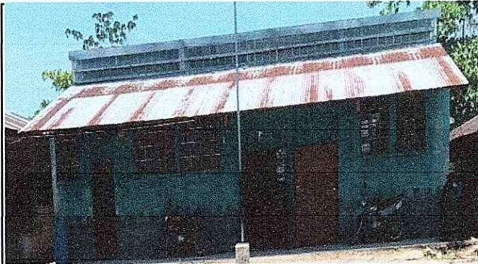
Foto1: Sustitución de láminas y reparación de puertas.
